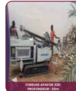
FOREUSE APAFOR 320: PROFONDEUR : 20m
