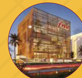
TEYCO Projet de Construction du siège de Free à Diamniadio
